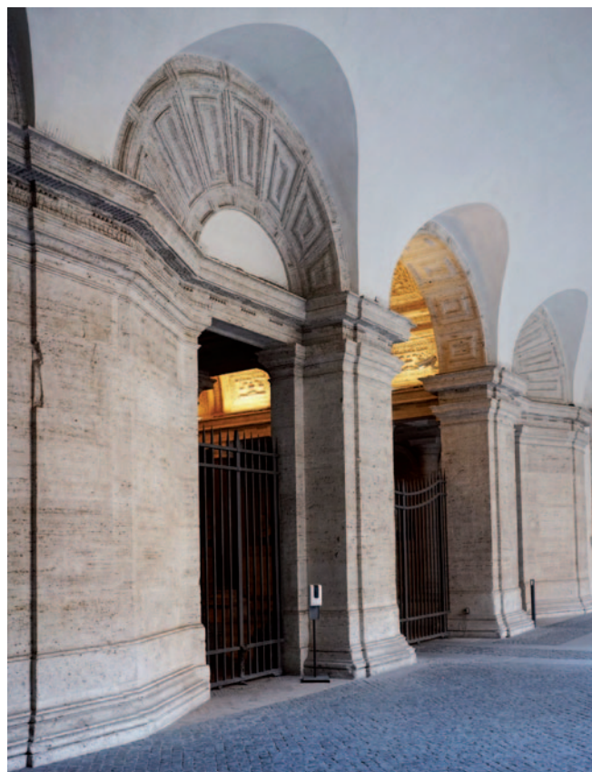
Fig. 5. Roma, palazzo Farnese, archi obliqui della galleria porticata.
