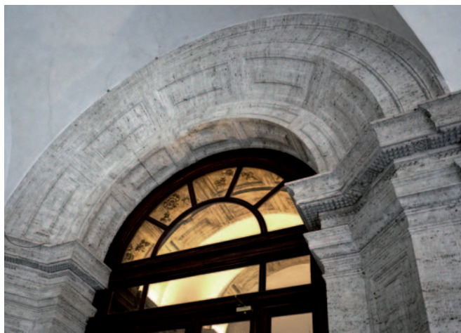
Fig. 7. Roma, palazzo Farnese, arco strombato e capialzado allo sbocco della scala principale.
