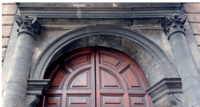
Fig. 11. Roma, palazzo Balami, arco obliquo del portale situato in via della Scrofa.
