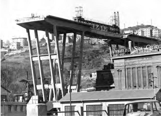
Fig. 8. R. Morandi, le pile di appoggio delle campate di luce minore con il varo di una trave prefabbricata (Archivio Centrale dello Stato, fondo Morandi).
