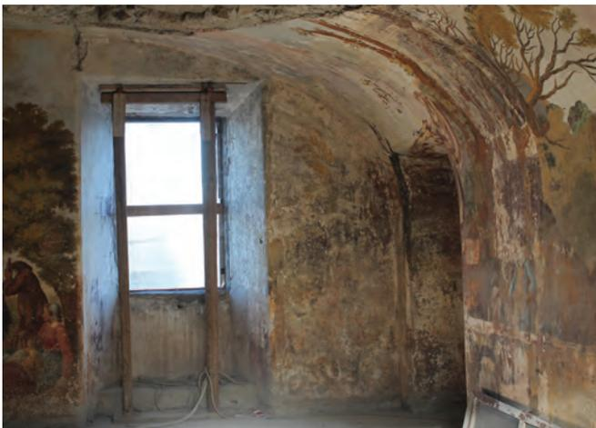
Fig. 13. La Sala Militare con dettaglio dell'innesto della nuova volta e spessore che la distingue dall'originale (2019).
