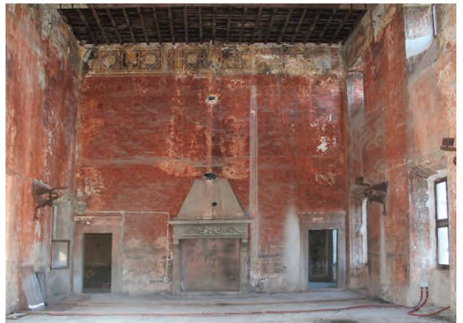
Fig. 14. La Sala degli Stemmi con estradosso della volta ricostruita in cemento armato e tracce dell'impianto elettrico. Completamente assenti finitura superficiale e pavimentazione (2019).
