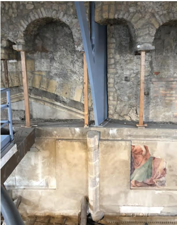
Fig. 2. Duomo di Napoli, sottotetto dell'abside, dettaglio della parete frontale con i resti della cupola sovrapposti all'arcata trionfale angioina (foto dell'autrice).
