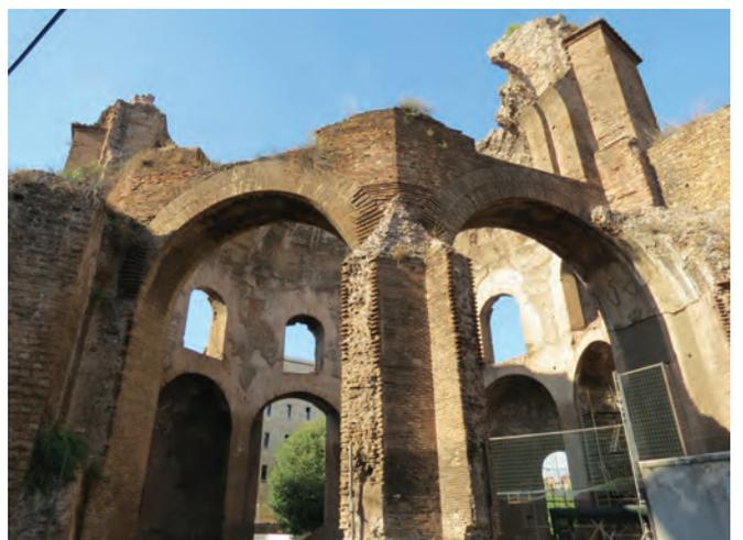
Fig. 9. Il versante sud-orientale con il pilastro e i due archi di raccordo ottocenteschi (lato via Giolitti) prima del restauro.
