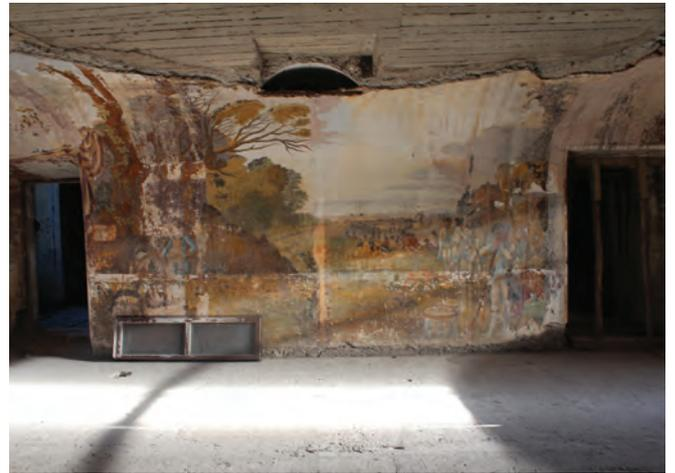
Fig. 12. La Sala Militare con le ripristinate lunette di epoca Braschi e la nuova struttura voltata che accompagna le pareti originali affrescate (2019).
