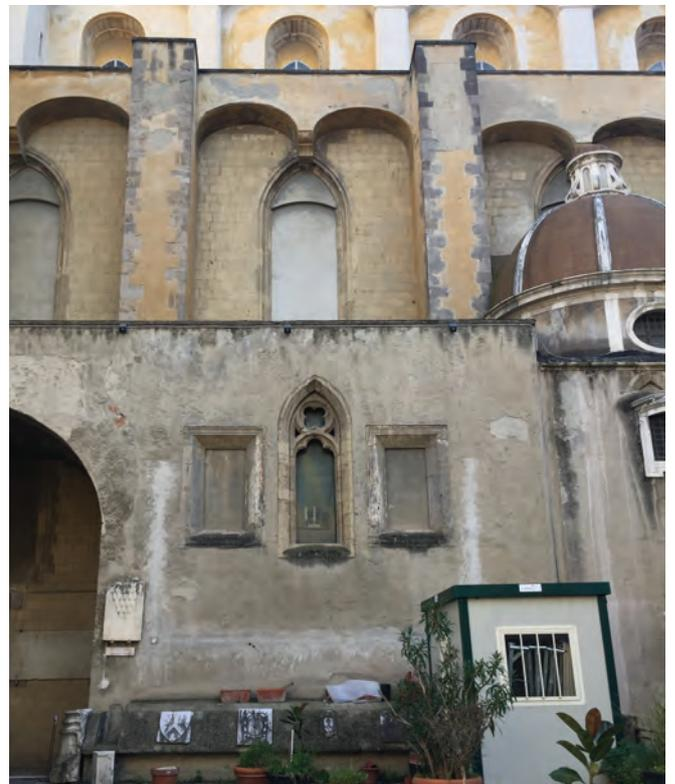
Fig. 3. Duomo di Napoli, dettaglio del prospetto laterale sinistro con i pilastri e gli archi del consolidamento susseguente il terremoto del 1456 (foto dell'autrice).
