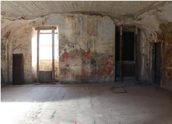
Fig. 11. La Sala Militare con la volta ricostruita in cemento armato e gli affreschi originali sulle pareti perimetrali (2019).
