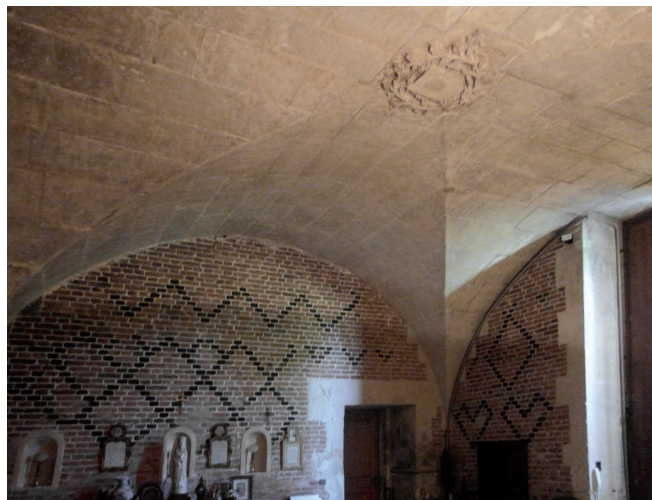
Fig. 2. Château di Acquigny (Eure, Normandia), volta a crociera.
