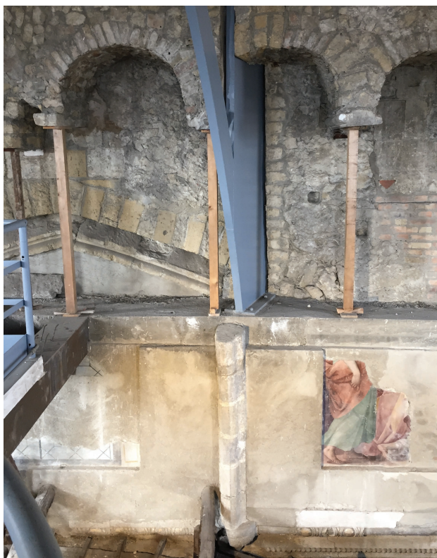
Fig. 2. Napoli. Duomo, sottotetto dell'abside, dettaglio della parete frontale con i resti della cupola sovrapposti all'arcata trionfale angioina (foto dell'autrice).
