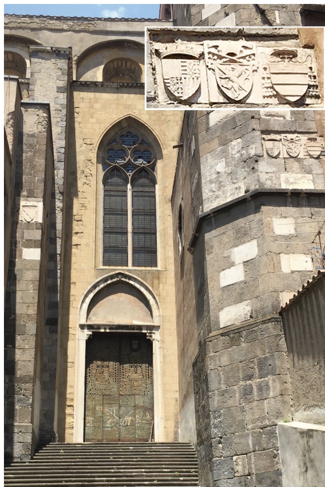
Fig. 4. Napoli. Duomo, dettaglio del prospetto laterale destro con evidenza degli stemmi incastonati nel contrafforte poligonale del transetto (foto dell'autrice).
