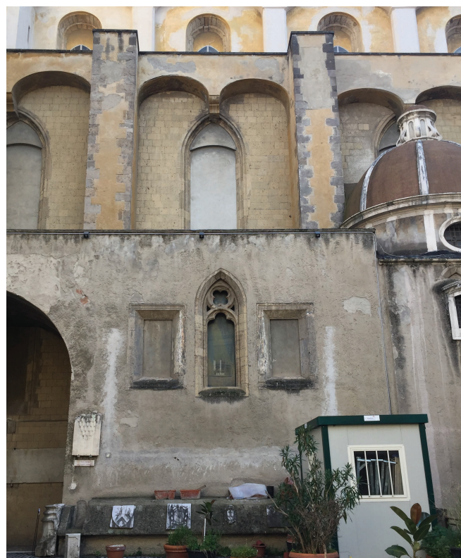
Fig. 3. Napoli. Duomo, dettaglio del prospetto laterale sinistro con i pilastri e gli archi del consolidamento susseguente il terremoto del 1456 (foto dell'autrice).
