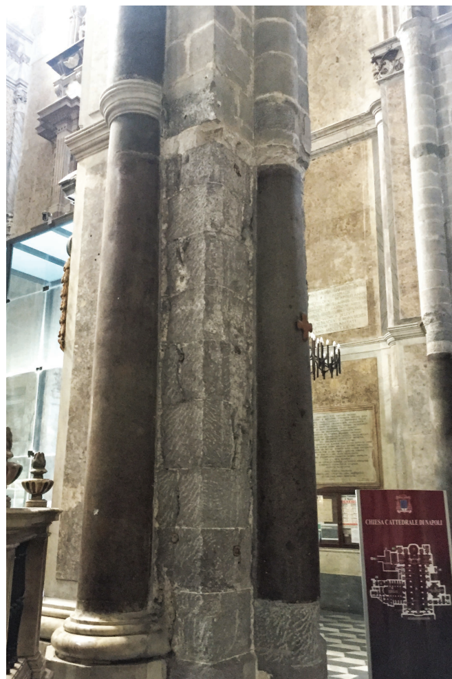
Fig. 5. Napoli. Duomo, i primi due pilastri sinistri della navata con a vista materiali e apparecchio degli elementi murari (foto dell'autrice).
