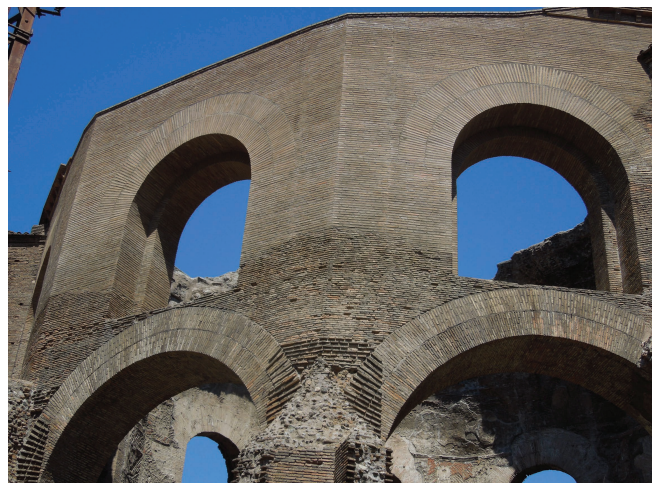
Fig. 13. Il fronte su Via Giolitti dopo il restauro.
