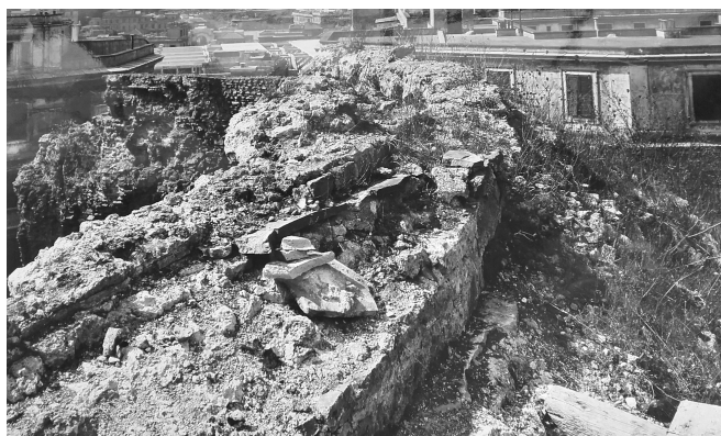
Fig. 10. I gradoni della cupola in avanzato stato di degrado (foto © MiC, Museo Nazionale Romano Archivio SAR, b.275/7).
