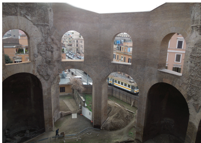
Fig. 15. Interno del monumento dopo il restauro.
