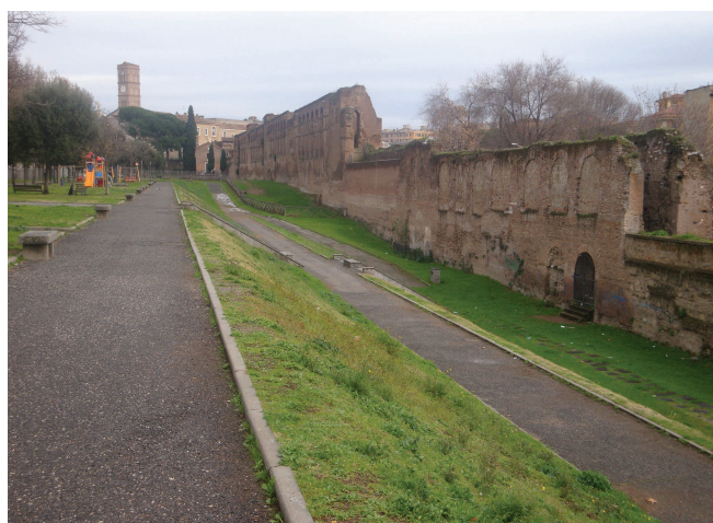
Fig. 5. Roma. Mura Aureliane, settore G, interno delle mura dopo i restauri in occasione del Giubileo del 2000.
