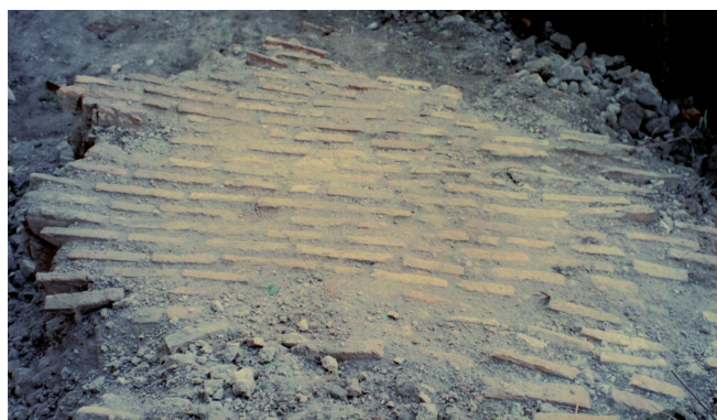
Fig. 12. Roma. Mura Aureliane, settore G, cortina crollata alla base del muro (1995).
