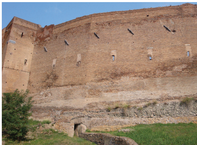
Fig. 1. Roma. Mura Aureliane, cortina L10-11, si osservano le fondazioni scoperte e il rapporto con una struttura preesistente.
