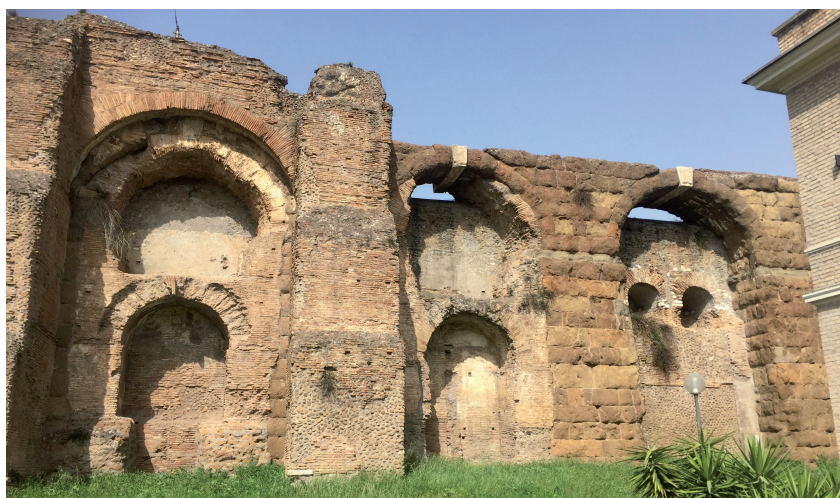
Fig. 3. A sinistra una porzione dell'Acquedotto che, per l'adiacenza alle Mura Aureliane, risulta tamponato; si notano i rinforzi laterizi ma si apprezza la tessitura a blocchi originale. A destra, nell'immagine di un masso di concrezione di consolidamento, superstita al pilastro che rinforzava, si osserva l'impronta dei blocchi.
