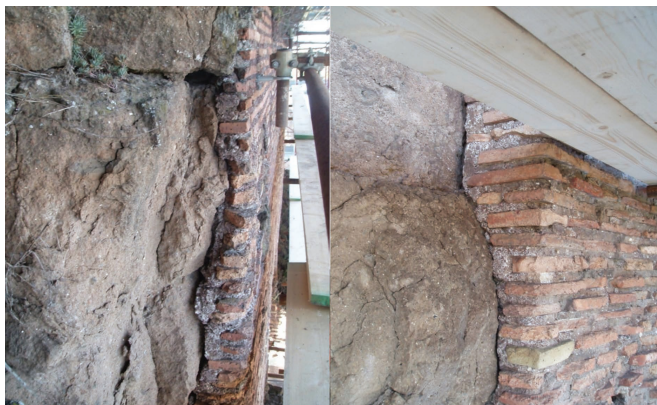
Fig. 6. Due viste ravvicinate della cortina laterizi addossata con evidenti intenti protettivi alla struttura a blocchi.
