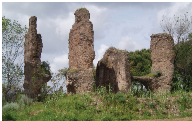
Fig. 5. I resti superstiti alla spoliazione cinquecentesca costituiti dai consolidamenti in concrezione (difficilmente riutilizzabili) privati anche del rivestimento laterizio. Le masse si mantengono ancora in una incerta stabilità che si riduce all'avanzamento del degrado, accelerato dalla mancanza di protezioni.
