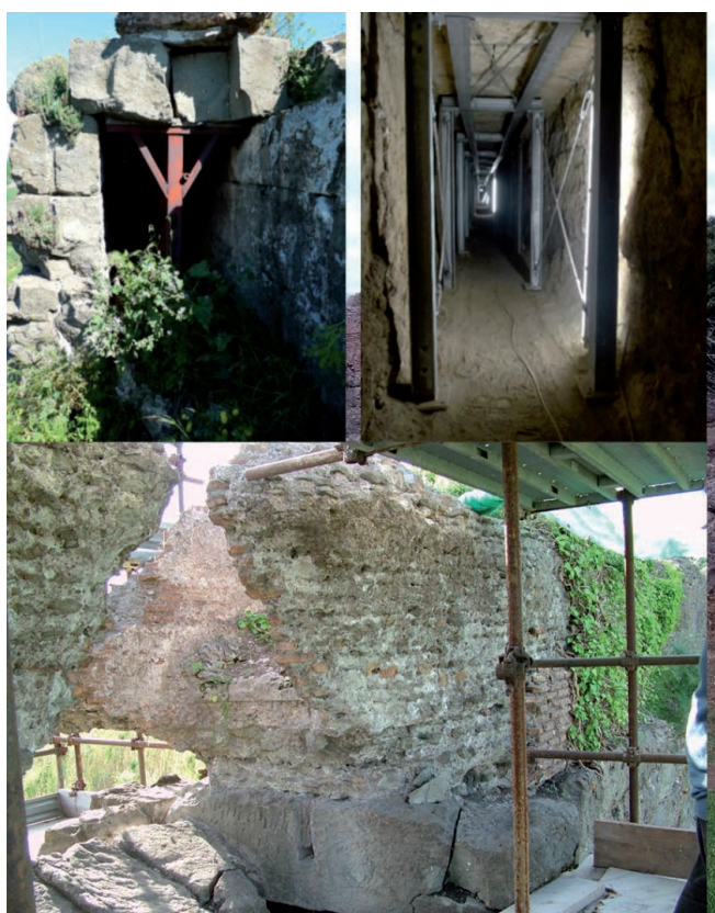
Fig. 12. In alto a sinistra i sostegni metallici inseriti negli anni Ottanta (puntelli) e dopo il Duemila (telai). In basso il crollo delle lastre di copertura dello speco del Claudio (avvenuto in questo tratto vicino Capannelle e temuto negli altri). A destra una serie di planimetrie che analizzano le condizioni delle lastre di peperino evidenziando la gravità delle fessurazioni in relazione ad eventuali crolli (rosso più grave, verde meno grave, giallo condizione intermedia). L'analisi è stata compiuta per un tratto adiacente il casale di Romavecchia e avrebbe potuto portare alla realizzazione di interventi meno invasivi dei precedenti che tuttavia non è stato possibile eseguire (sono state inserite strutture interne di sostegno provvisorio).
