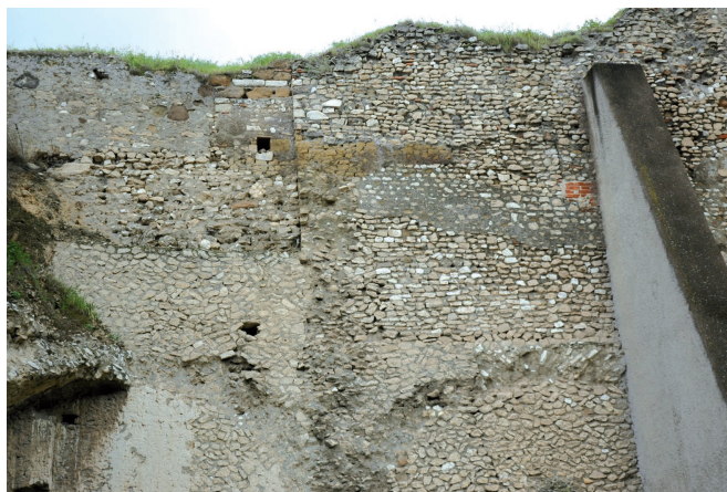
Fig. 3. Santuario, strada degli Orti (fig.1, nr. 1), A) parte residua del crollo di I fase B) strutture della ricostruzione di II fase.
