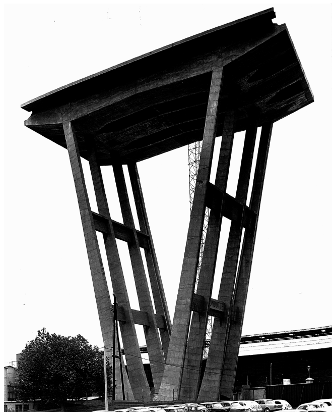
Fig. 4. R. Morandi, una delle pile delle luci minori completata (Archivio Centrale dello Stato, fondo Morandi).
