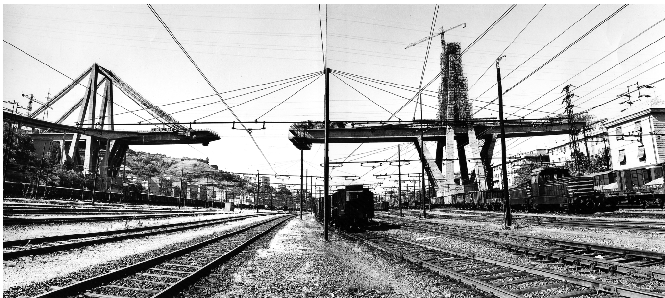
Fig. 7. R. Morandi, le pile di sostegno dei sistemi bilanciati in costruzione, visti dal parco ferroviario del Campasso (Archivio Centrale dello Stato, fondo Morandi).
