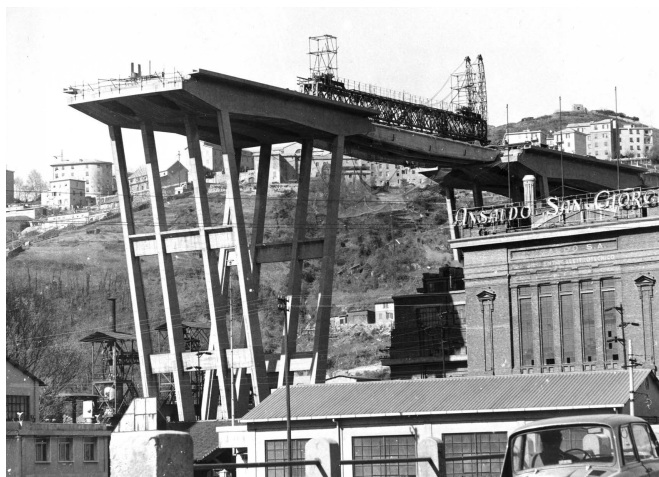
Fig. 8. R. Morandi, le pile di appoggio delle campate di luce minore con il varo di una trave prefabbricata (Archivio Centrale dello Stato, fondo Morandi).
