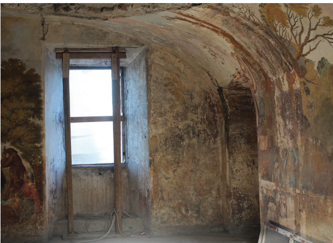
Fig. 13. La Sala Militare con dettaglio dell'innesto della nuova volta e spessore che la distingue dall'originale (2019).
