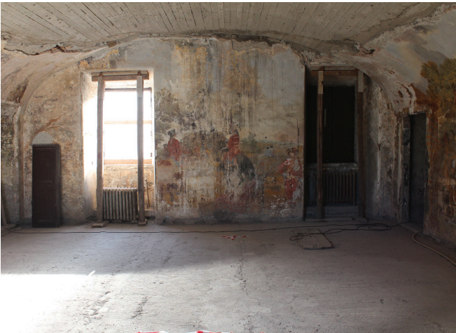
Fig. 11. La Sala Militare con la volta ricostruita in cemento armato e gli affreschi originali sulle pareti perimetrali (2019).
