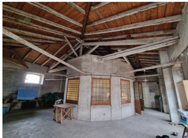
Fig. 6. Catania. Palazzo Biscari, veduta esterna della lanterna e del sistema di ancoraggio lineo alle falde del tetto (foto di D. Sutura).
