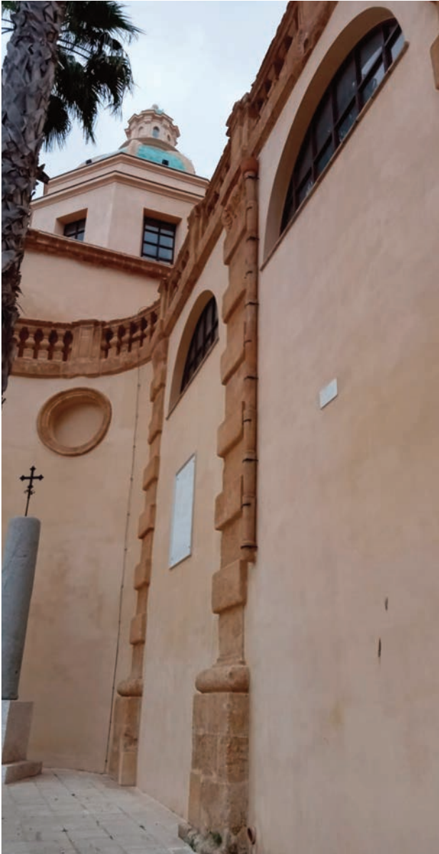
Fig. 41. Mazara. Cattedrale, particolare della curva di raccordo presbiterio-corpo longitudinale (foto di M. Riolo)
