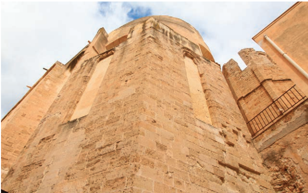
Fig. 78. Trapani. Chiesa di San Domenico, vista dell'esterno dell'abside con i resti della struttura tardogotica e del suo interno trasformato in età Moderna (foto di G. Nuccio).
