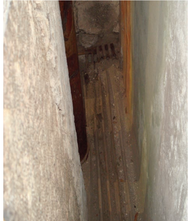
Fig. 67. Trapani. Chiesa di San Domenico, cappella del SS.mo Crocifisso, particolare dell'intercapedine lungo la cornice con i binari per lo scorrimento dei pannelli riproducenti i "misteri dolorosi" (foto di L. Biondo).
