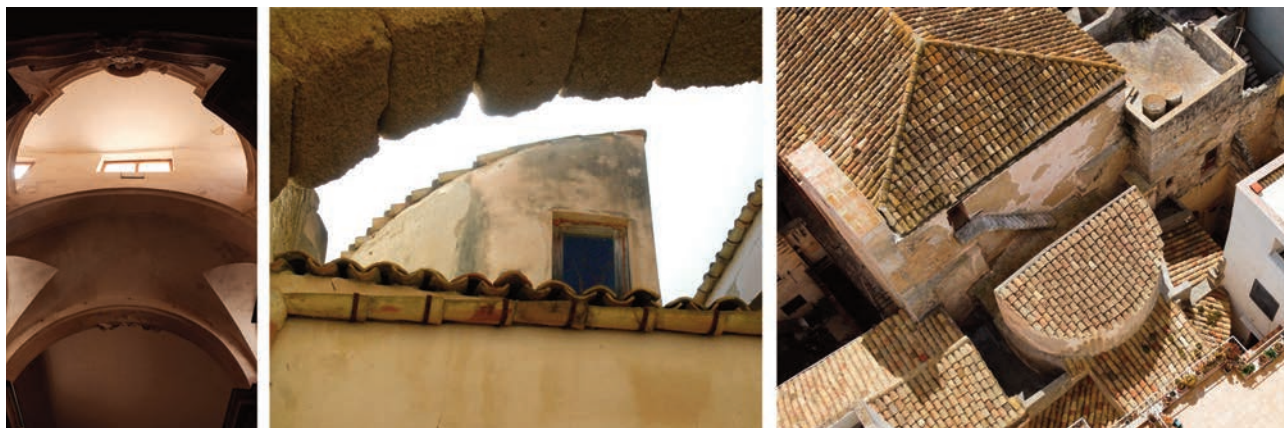
Fig. 63. Trapani. Chiesa dell'Immacolatella, veduta interna del congegno di copertura della tribuna (a sinistra); veduta esterna della camera di luce (al centro); veduta dall'alto del sistema delle coperture della tribuna (foto di M. Cannella).
