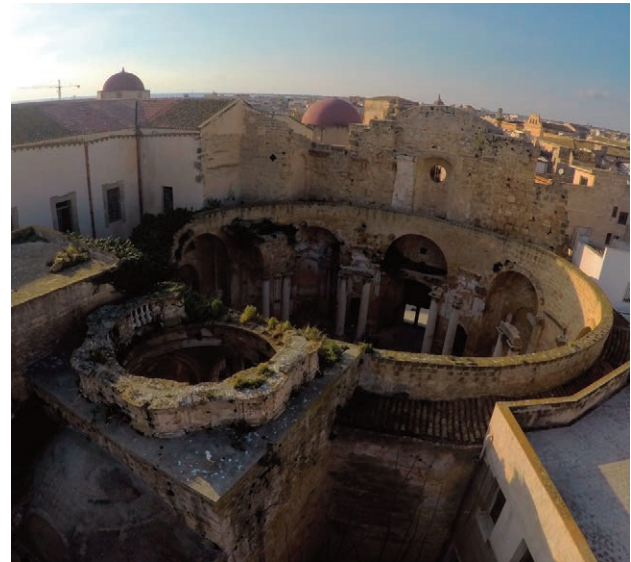
Fig. 4. Mazara. Chiesa di Sant'Ignazio, veduta esterna, particolare della rotonda presbiteriale e dei resti della base ottagonale (foto di C. Borruso).
