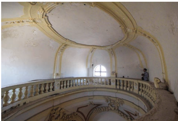
Fig. 82. Trapani. Chiesa della SS. Annunziata, vista interna del sistema a camera di luce (foto di G. Nuccio).
