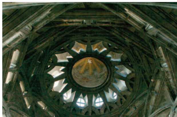
Fig. 40. Torino. Lanternino della cappella della Sindone dopo i lavori di restauro (fotografia di Ernani Orcorte, da FERROGGIO, 2022, p. 203).
