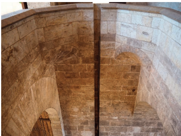
Fig. 3. Valencia. Torri di Quart, galleria/balcone interno della tribuna centrale (foto A. Antista).
