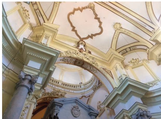
Fig. 81. Trapani. Chiesa della SS. Annunziata, vista dalla navata verso la copertura a camera di luce (foto di D. Sutera).
