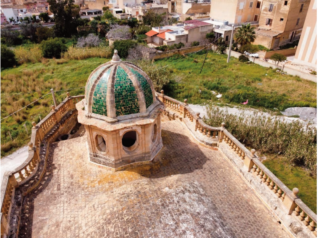
Fig. 40. Marsala. Chiesa di Santa Maria della Grotta, veduta esterna della lanterna e della curva di raccordo presbiterio-corpo longitudinale (foto di M. Cannella).
