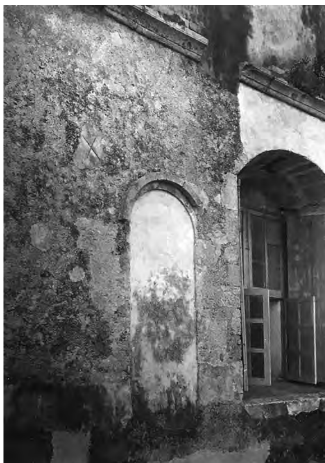
Fig. 9. Le monofore normanne tamponate a fianco dei finestroni settecenteschi nel 1907 (da Rao, 1907).
