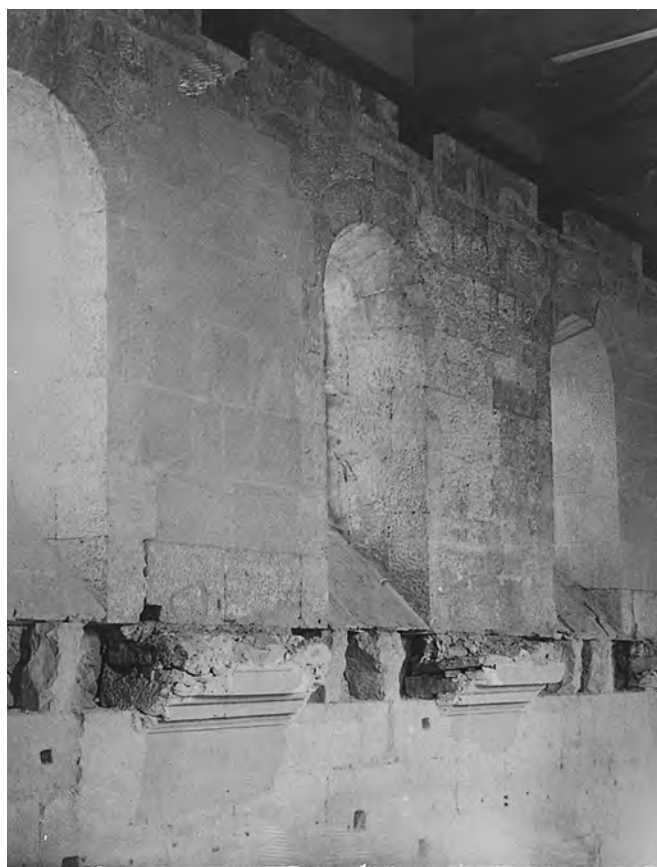
Fig. 14. L’ordine superiore della navata centrale durante i lavori di rimozione delle decorazioni. È possibile apprezzare il rifacimento di parte della muratura in corrispondenza della prima monofora e dello stipite destro della terza (Archivio fotografico della Soprintendenza di Siracusa).
