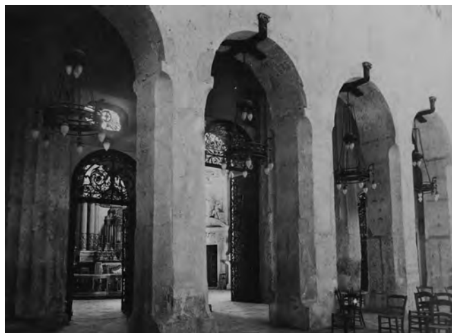
Fig. 13. Il fianco meridionale della navata, dopo lo scrostamento del rivestimento, lo smusso delle pilastrature e l'inserimento dei nuovi lampadari (Archivio fotografico della Soprintendenza di Siracusa).
