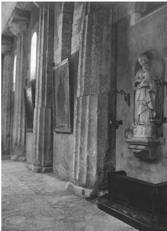
Fig. 10. La navatella settentrionale dopo la rimozione degli altari e lo scrostamento delle colonne (Archivio fotografico della Soprintendenza di Siracusa).
