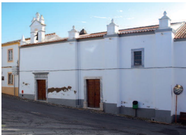
Fig. 12. Castro Verde. Casa da Misericórdia, fachada principal lateral.
